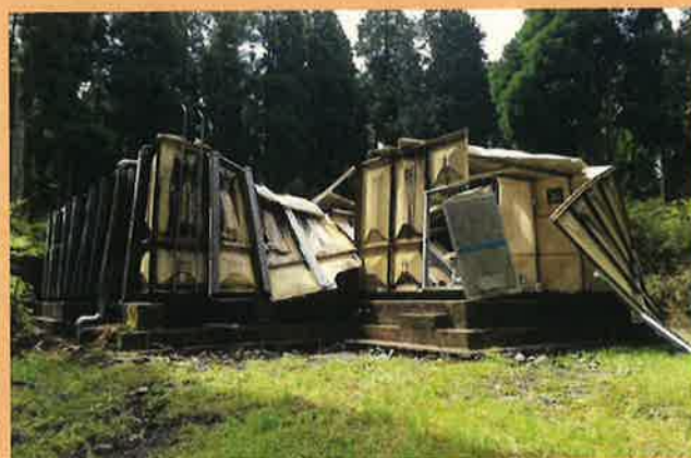
2016年 熊本地震 FRPパネルタンクの被害
