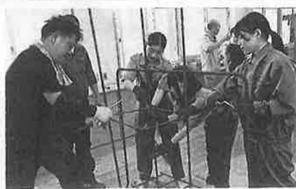
鉄筋を組み立てる生徒
